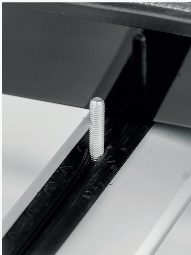
Bolten føres gjennom tape fra bunnen og opp i boksen
